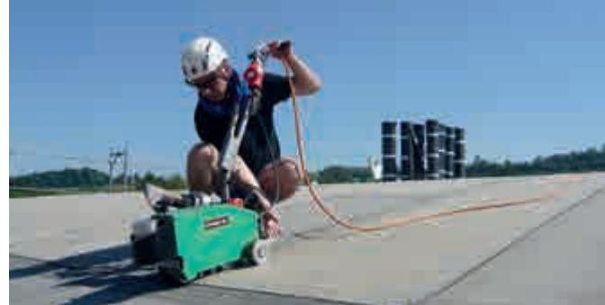
Zavarivanje modifikovanog bitumena korišćenjem BITUMAT B2.
